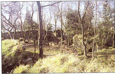
Gotorlekua barnealdea. Interior del fuerte.
