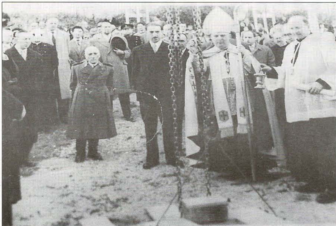
El obispo bendiciendo la primera piedra de la obra salesiana ante la presencia de autoridades y vecinos
