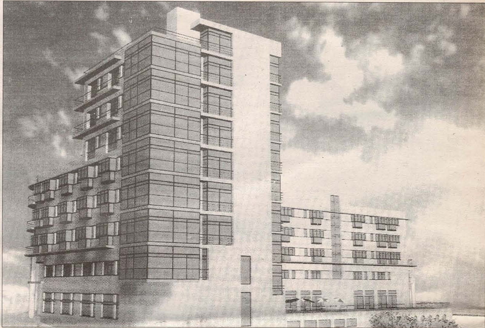
Aspecto que ofrecerá el primero de los dos edificios, actualmente en construcción
