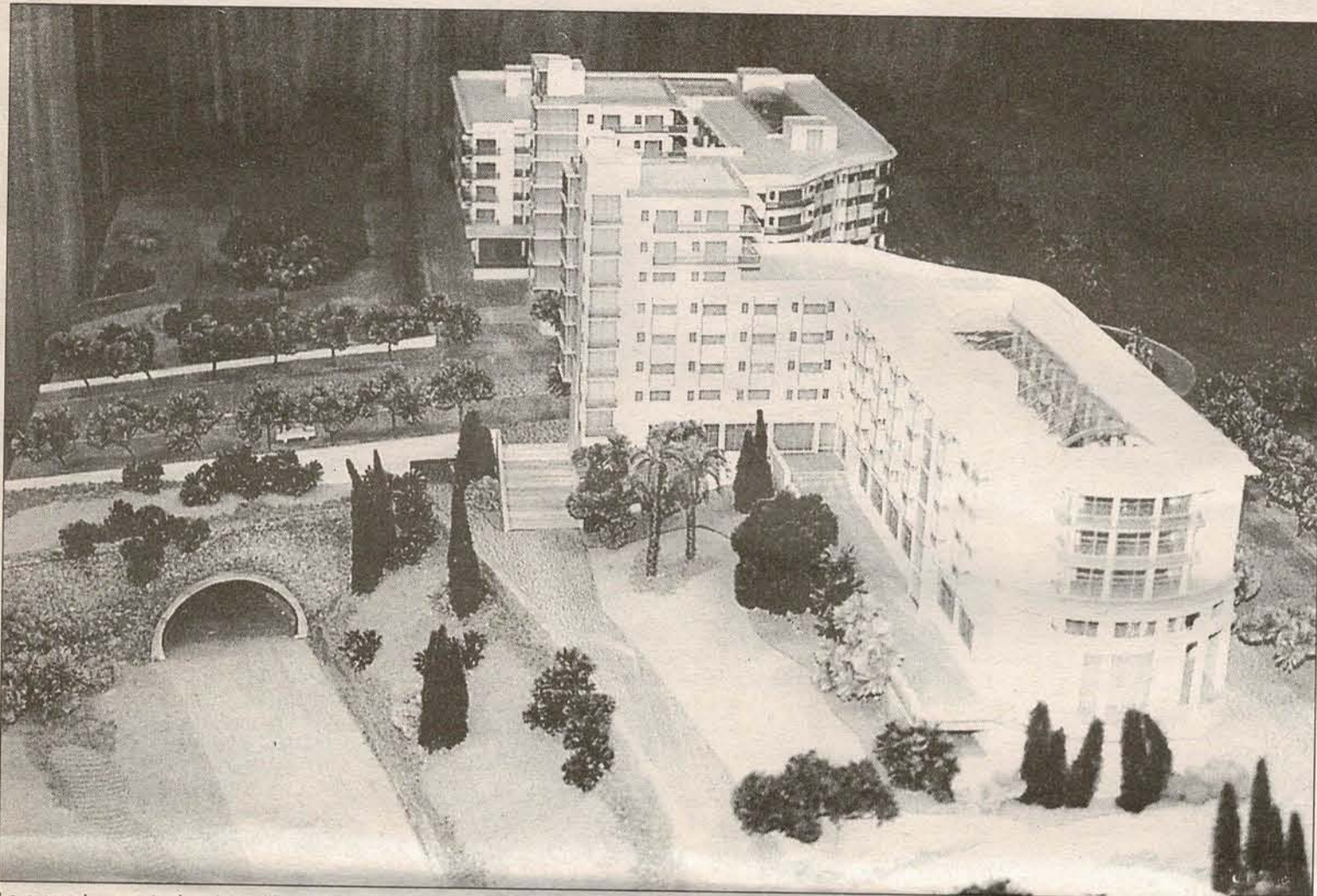
La maqueta muestra los dos edificios que compondrán el apartahotel, habiéndose iniciado la construcción del bloque que se encuentra en primer plano
