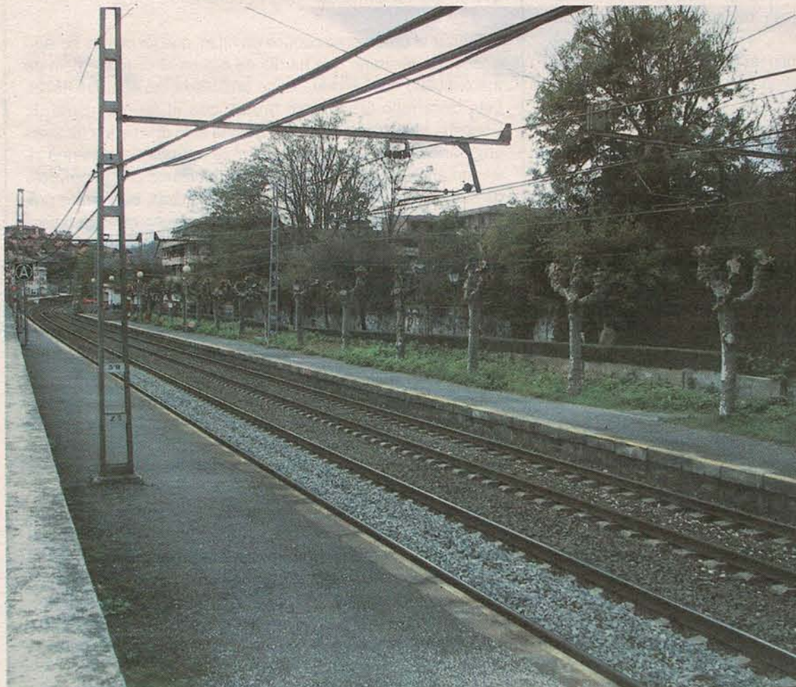
Parte de las vías que serán soterradas
