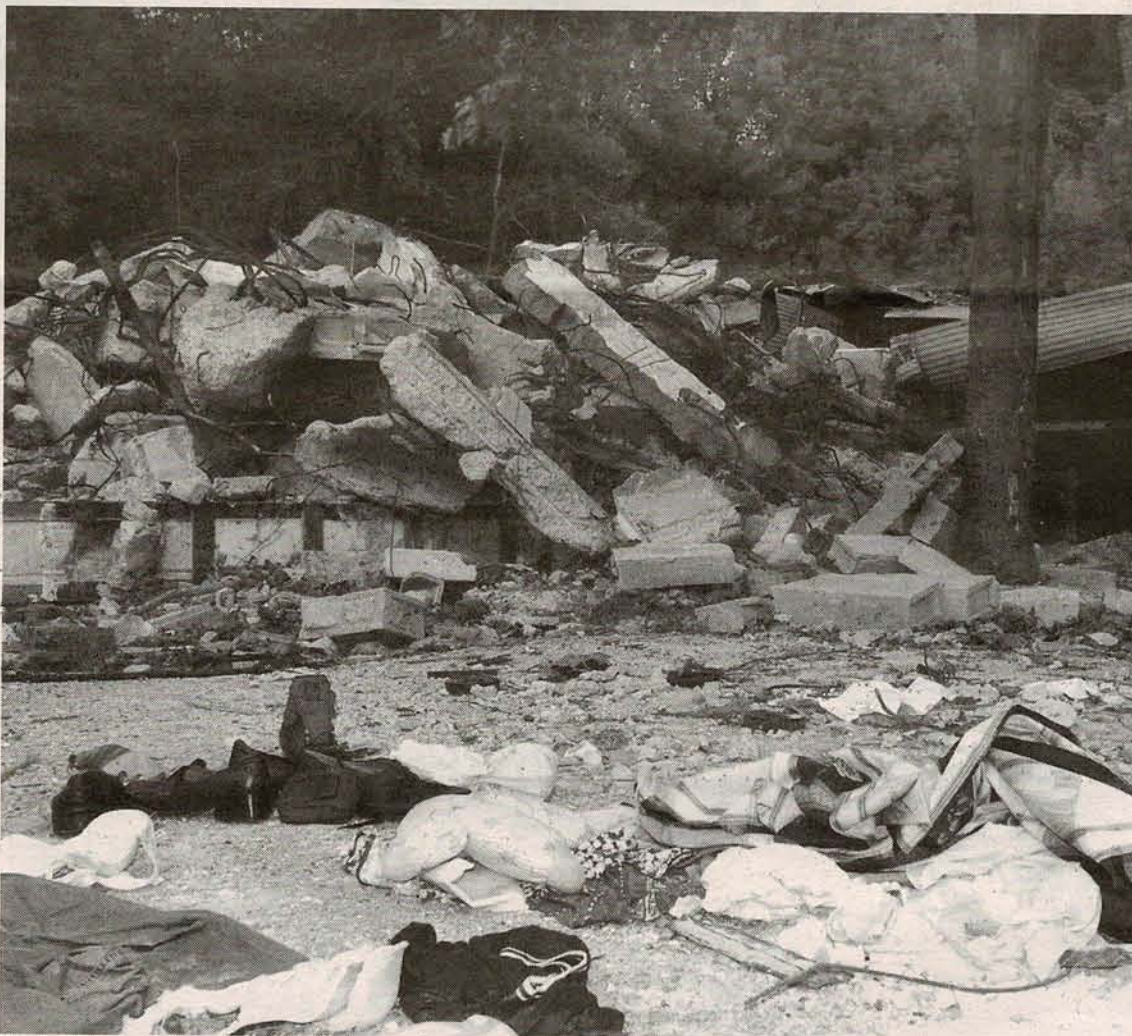
Escombros del antiguo edificio
