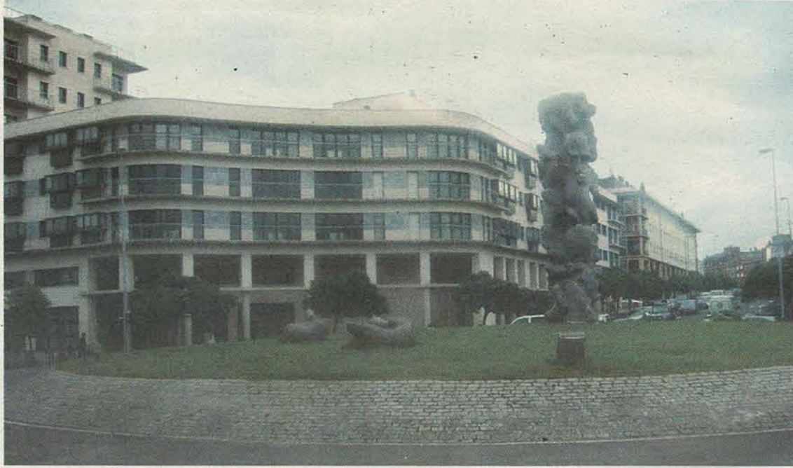
Uno de los accesos de la estación de topo será por la plaza de Sagastieder
