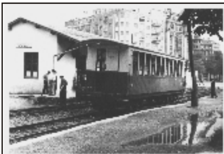
RC 1 sin reformar en Amara. Foto: MVF.
