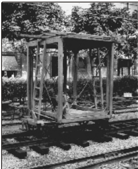
Castillete de línea aérea del Topo. Foto: Kepa.
