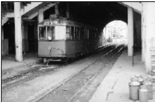
El MC 30 llenando en Irún los calderines con aire comprimido para el freno. Foto: MVF.
