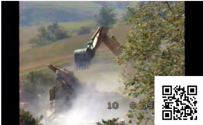
Vídeo del derribo de la perrera
