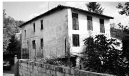
Vista exterior del caserío situado a orillas del Urumea.
