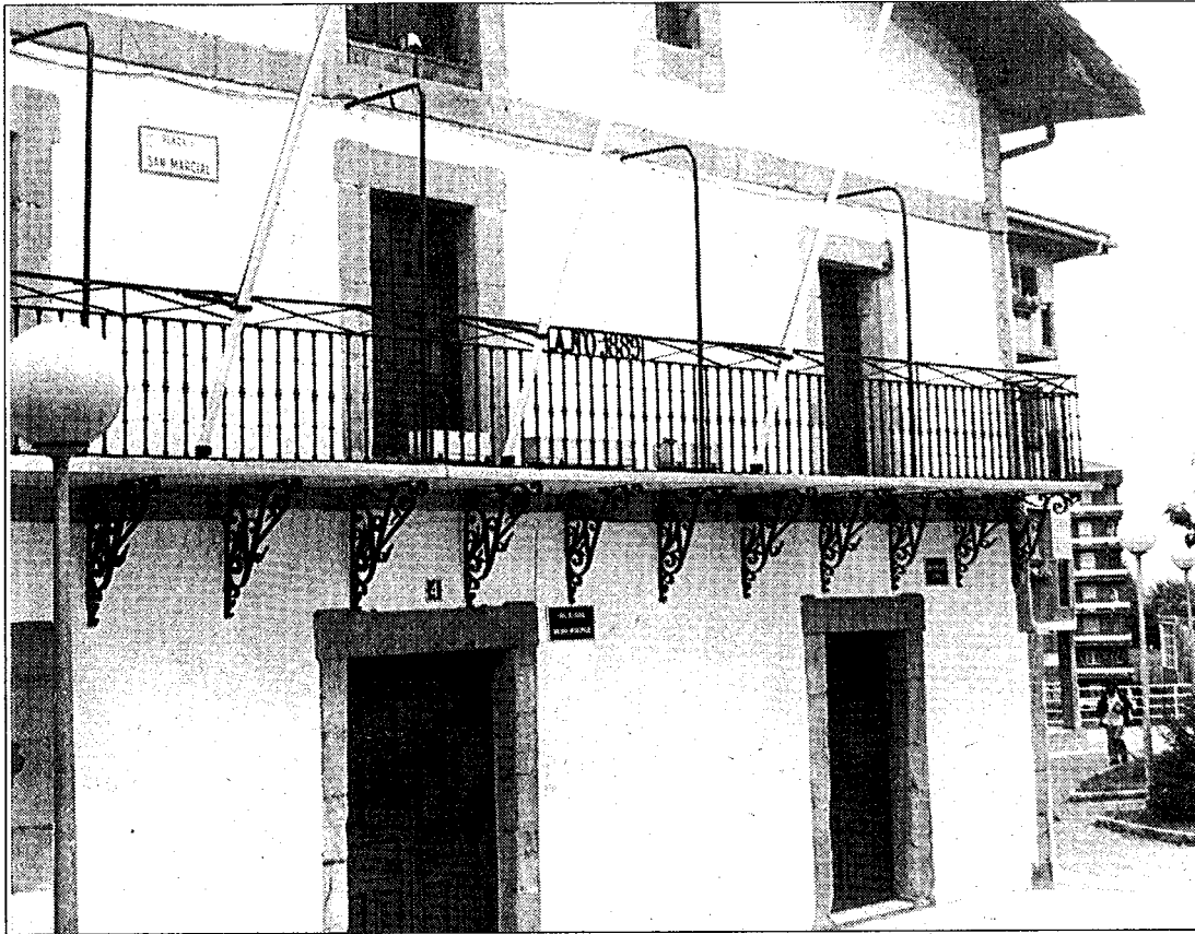
La oficina se encuentra en el edificio de la Tenencia de Alcaldía.
