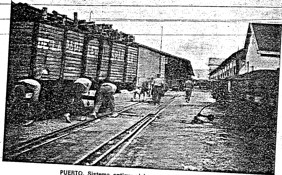
PUERTO. Sistema antiguo del movimiento de vagones
