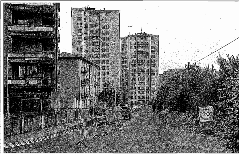
La acera del Paseo de Altza va a ser ensanchada.
