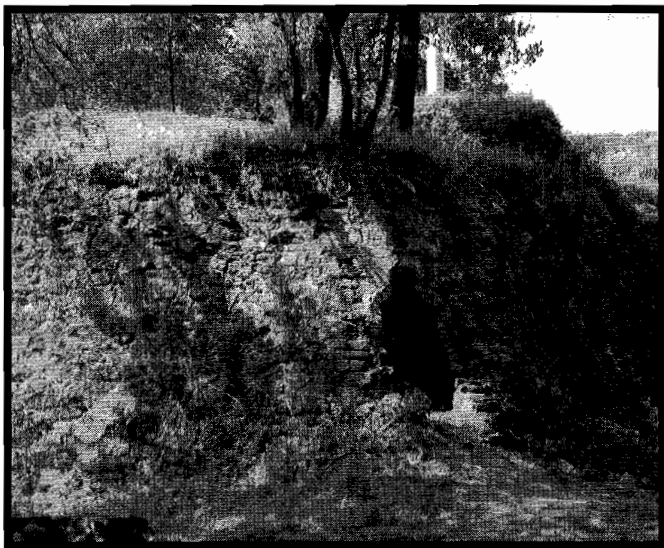
Ametzagainako gotorlekua sasiz eta zikinkeriaz garbitu dute eta San Markoseko gotorlekua ere eraberritua dago.
