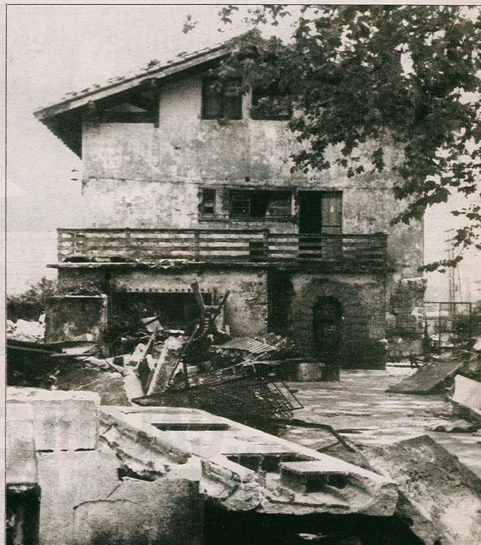
Todas las casetas fueron destruidas por técnicos municipales. (Foto Pemán).
