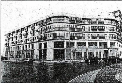
Vista exterior de la residencia de Intxaurreondo, Txara-1, POSTIGO
