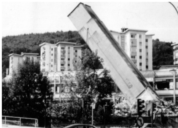
Derribo de la torre de Contadores
